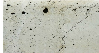
beton - een betonnen vloer
